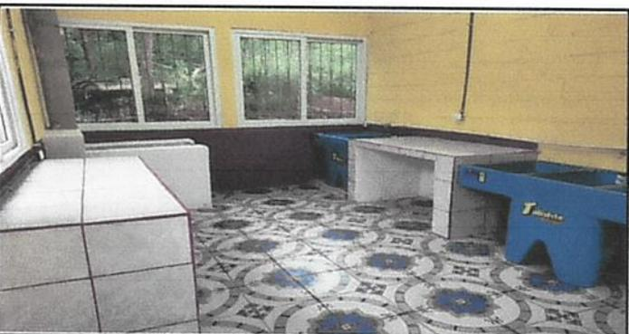
Foto 5: Sustitución de piso de torta de concreto a piso cerámico antideslizante
